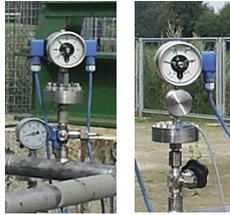
Vorher (links): mechanischer Druckmessumformer mit Rohrfeder. Nachher (rechts): digitaler Druckmessumformer mit mechanischem Anzeigegerät.
